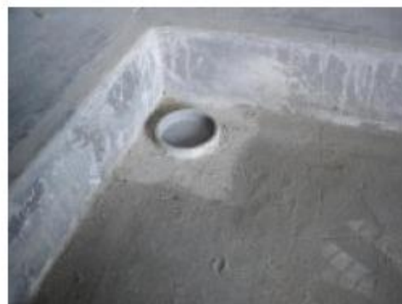
Narożnik po osadzeniu ramy
