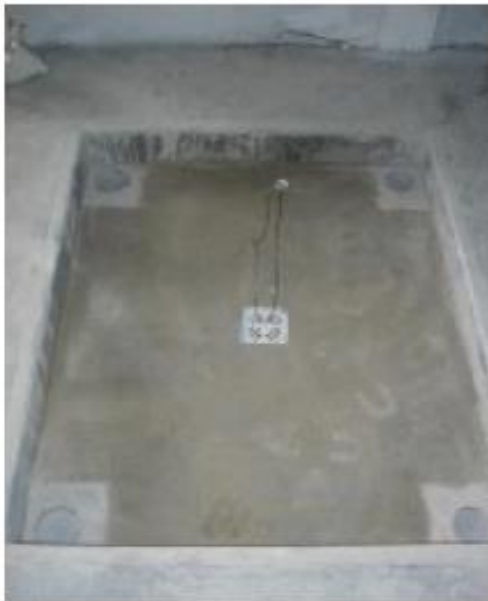
Widok całej ramy po osadzeniu.
